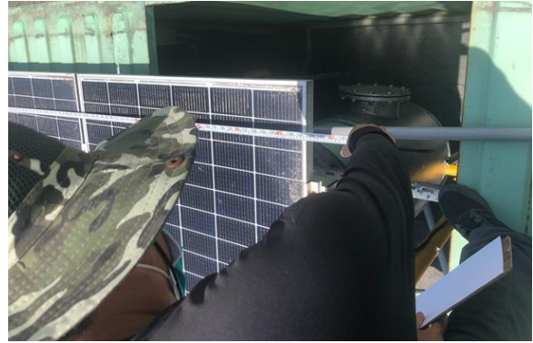
圖 2 為針對獨立型太陽光電系統進行相關尺寸測繪。
